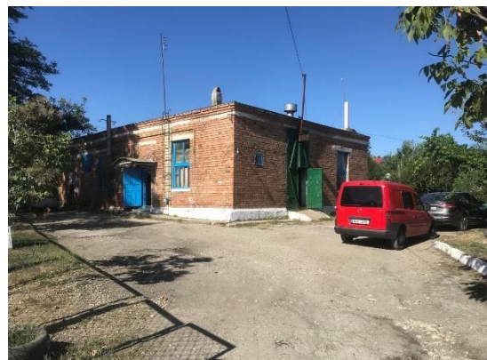
Figura 5. Stația de pompare a apelor uzate Bulboaca
