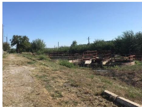
Figură 2. Stația de epurare a apelor menajere
