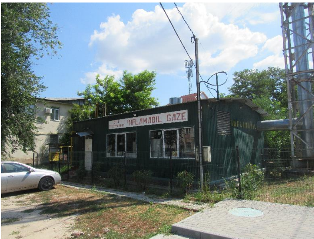
Fig. 10 Centrala termică a Antermo din Anenii Noi
