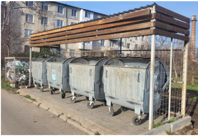
Foto7. Platformă de colectare a deșeurilor
