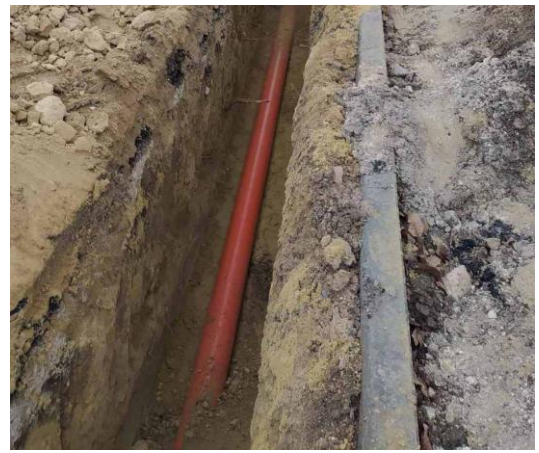
Foto 8. Extinderea sistemului de canalizare
